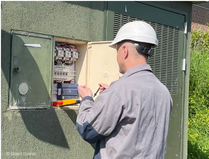
USEDAROC-Schaltschrankinstallation. USEDAROC electrical panel installation.
