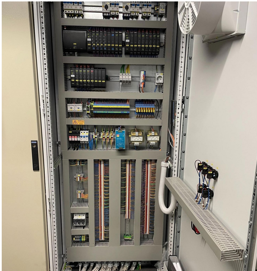
Control cabinet in Germany's largest BACnet/SC-based property © Tino Erler, SI-Building Automation Schaltschrank in Deutschlands größter BACnet/SC-basierter Liegenschaft © Tino Erler, SI-Building Automation
