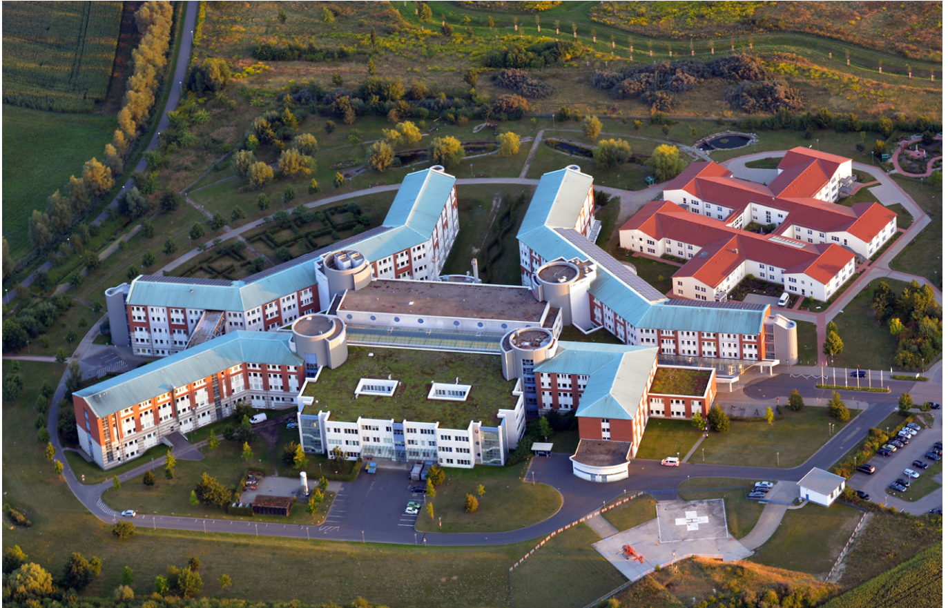
The Güstrow site in Mecklenburg-Western Pomerania is one of several KMG Kliniken facilities where the building automation infrastructure has been upgraded. Der Standort Güstrow in Mecklenburg-Vorpommern ist eine von mehreren Einrichtungen der KMG Kliniken, an denen die Infrastruktur der Gebäudeautomation erneuert wurde. © KMG Kliniken
