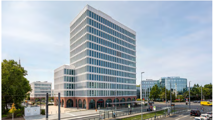
“The One” exterior view | „The One“ Außenansicht © SAUTER
