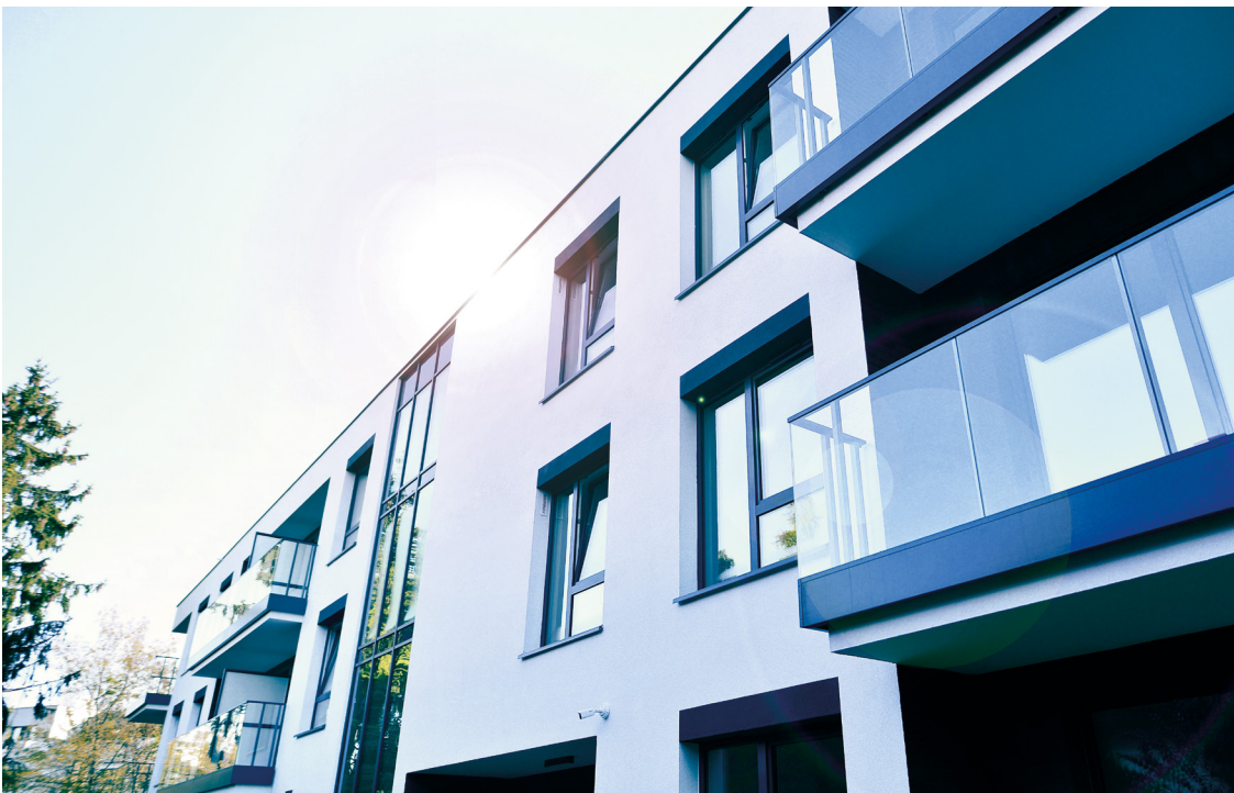
A luxury multifamily residential building in New Jersey | Ein luxuriöses Mehrfamilienhaus in New Jersey © Foto Grand Warszawski / Adobe Stock
