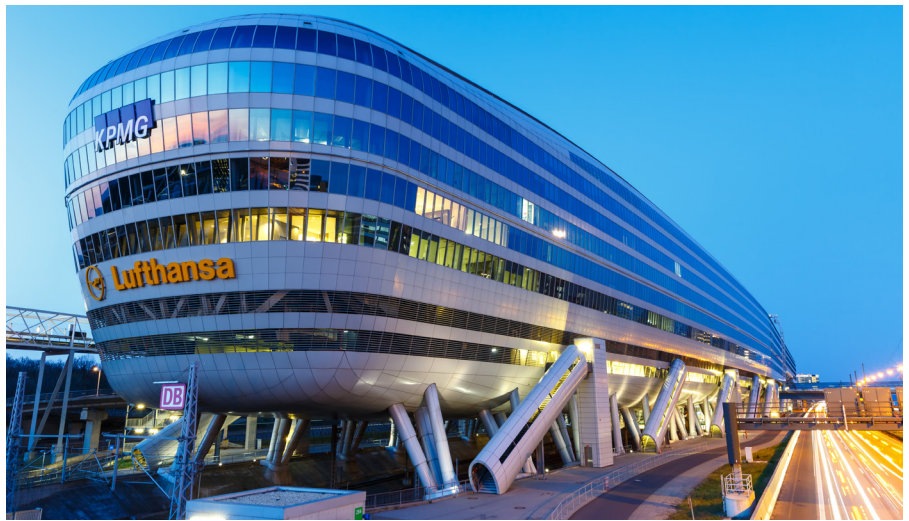
The Squire, Frankfurt Airport uses 16,000 battery-less, wireless sensors (Source Hermos AG) / Das „The Squire“ am Frankfurter Flughafen nutzt 16.000 batterieleose, drahtlose Sensoren (Quelle: Hermos AG) © iStock
