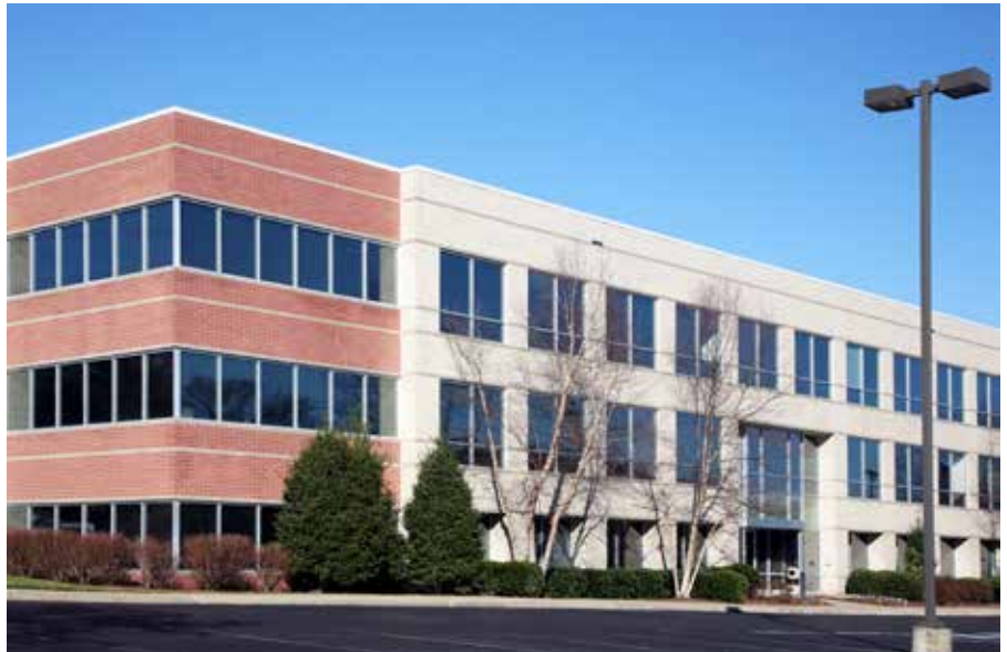
Wireless BACnet enabled a gradual LON-to-BACnet migration at a three-story office building Wireless BACnet ermöglichte eine schrittweise LON-zu-BACnet-Migration in einem dreistöckigen Bürogebäude © shutterstock.com/g/jimmartin
