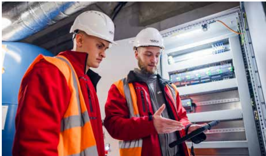
A prompt expert acceptance inspection demonstrates the diligence and experience behind HOSCH's services. Eine zügige Sachverständigenabnahme zeigt die Sorgfalt und Erfahrung in den Leistungen von HOSCH. © Pavol Putnoki
