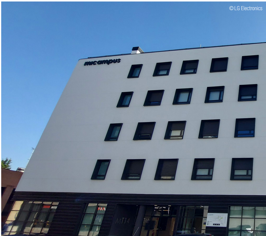
Hauptfassade des Gebäudes Micampus MT14. Micampus MT14: Principal facade of the building.
