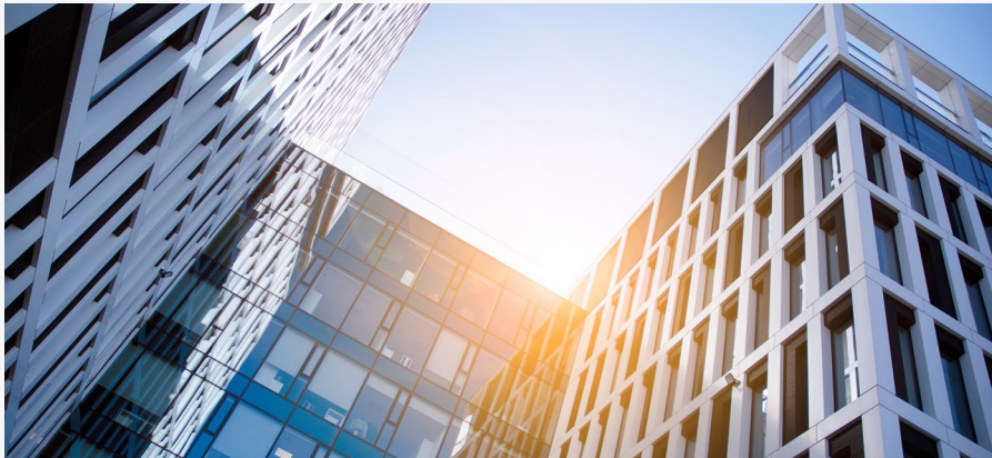
Mit dem GEG 2024 wurde für Nichtwohngebäude erstmals ein Mindest-Automatisierungsgrad eingeführt. The German GEG 2024 introduced a minimum level of automation for non-residential buildings for the first time.
