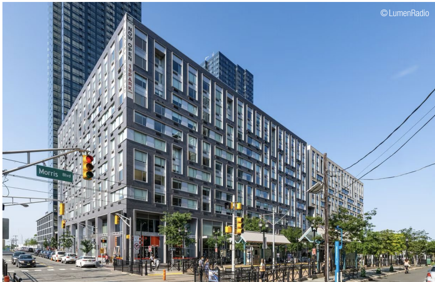
18 Park Avenue, Jersey City: Ausgestattet mit der BACnet-Funktechnologie von LumenRadio für ein effizientes, bedarfsgesteuertes Raumklima. 18 Park Avenue, Jersey City: Equipped with LumenRadio's wireless BACnet technology for efficient, demand-controlled indoor climate.
