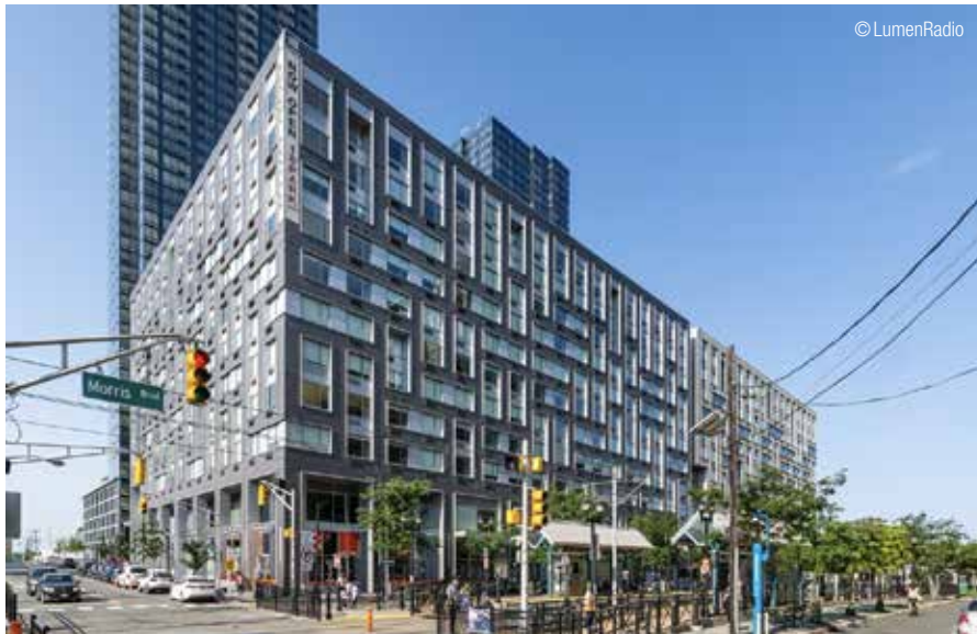
18 Park Avenue, Jersey City: Ausgestattet mit der BACnet-Funktechnologie von LumenRadio für ein effizientes, bedarfsgesteuertes Raumklima. 18 Park Avenue, Jersey City: Equipped with LumenRadio's wireless BACnet technology for efficient, demand-controlled indoor climate.
