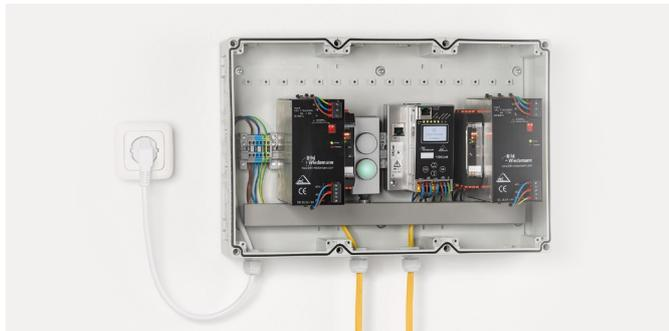
Fire Damper Stand-Alone control unit BW3545 from Bihl+Wiedemann: the pre-parameterized, ready to install and use complete solution for controlling and monitoring fire dampers and smoke extraction dampers or flow regulators. BSK-Stand-Alone-Steuereinheit BW3545 von Bihl+Wiedemann: die vorparametrierte, einbau- und anschlussfertige Komplettlösung für die Steuerung und Überwachung von Brandschutz- und Entrauchungsklappen oder von Volumenstromreglern.
