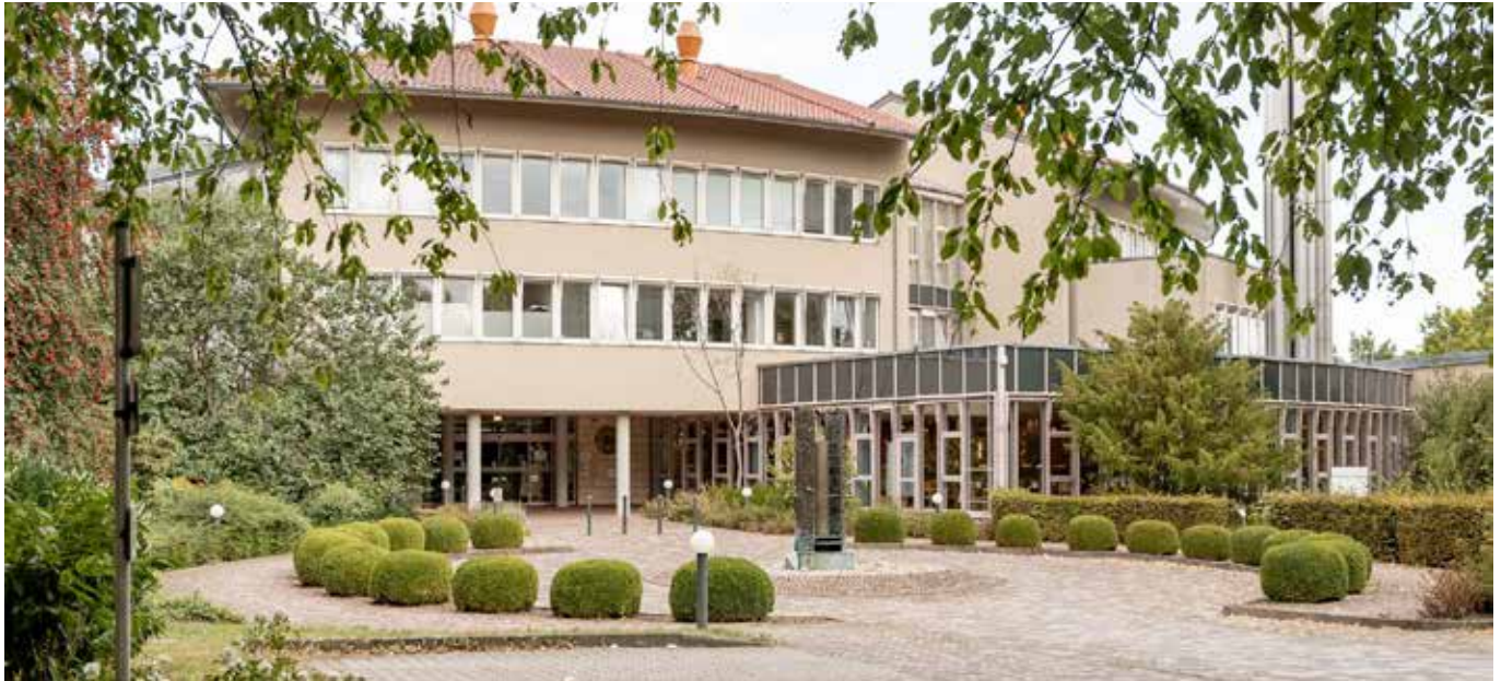
Rehabilitation clinic with efficient building automation. Reha-Klinik mit effizienter Gebäudeautomation.
